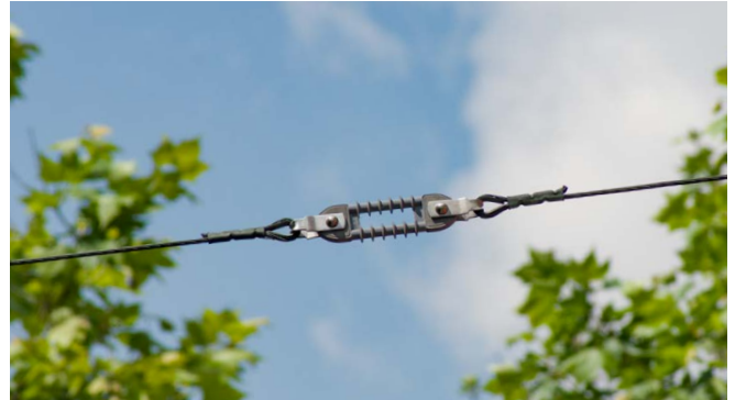
Loop insulator, Stadtwerke Augsburg
