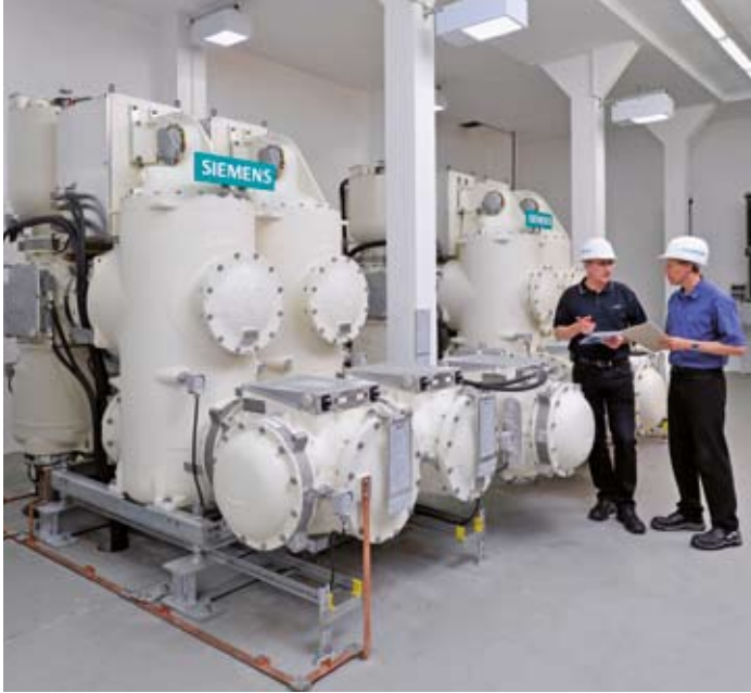
Die 8DN8 ermöglicht durch ihre modulare Bauweise ein Höchstmaß an Flexibilität im Anlagenlayout
