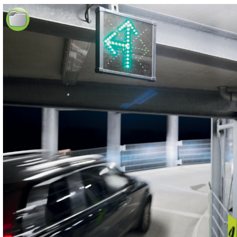
A PARKOLÁSI IRÁNYÍTÓ RENDSZEREK kerülő nélkül vezetnek el a legközelebbi állóhelyre – ahol villamos csatlakozó is lehet.
