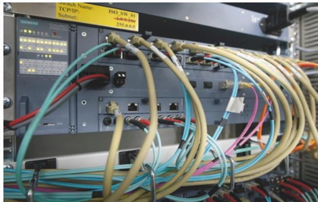
Bild 1: Redundantes 10-Gbit-Rückgrat für effiziente, bald virtualisierte Prozessführung: einer von zwei Industrial Ethernet Switches/Routern SCALANCE XR552-12M von Siemens für den Rack-Einbau.
