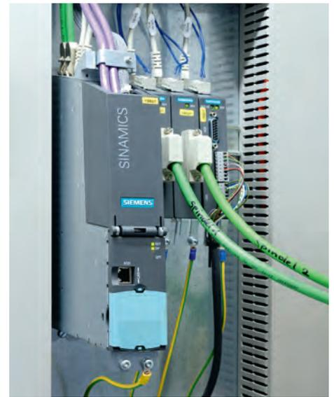
Die Control Unit der Antriebe regelt die Position der Schleifköpfe. Sie erhält von der Steuerung lediglich die Sollwerte.
