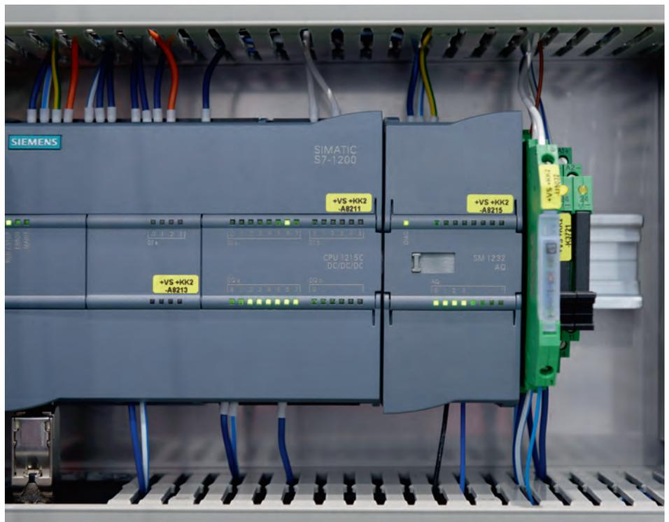
Die S7-1200 Steuerung überwacht in Echtzeit, ob ein Deckel aufgesetzt werden muss.
