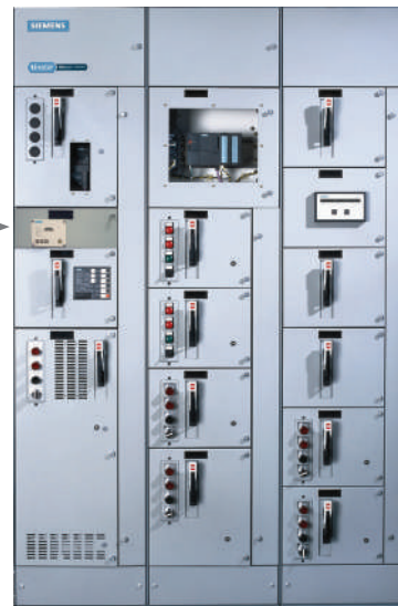
Installation du CCM TPS3 01
