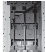
Assemblage de barre omnibus verticale isolée
