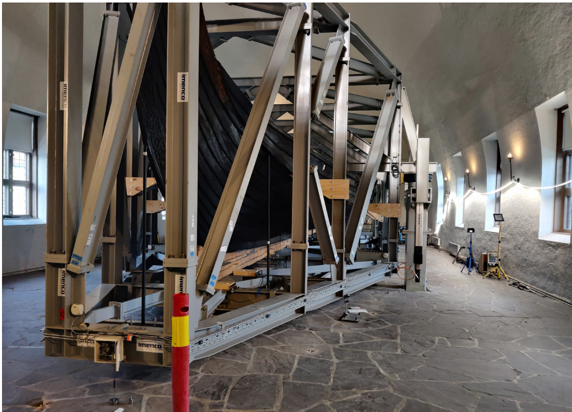
Flyttingen av Vikingskipene vil ikke skje før i 2025, men de er likevel allerede sikret mot eventuelle vibrasjoner under byggearbeidet.
