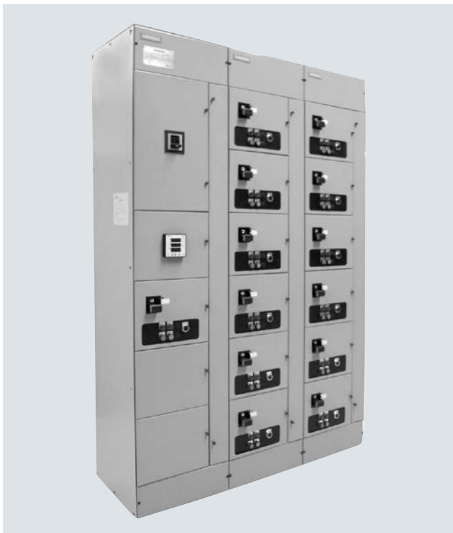
Centro de control de motores 8PX2000 (Figura 1)
