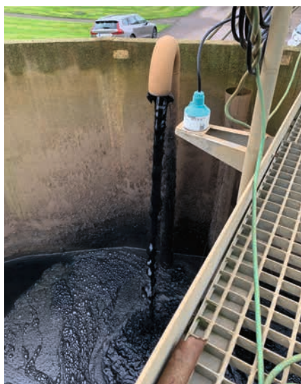
Siemens nya radarnivågivare Sitrans LR110 mäter nivån 0–5 m i slambassängen på ett av NSVA:s reningsverk.
