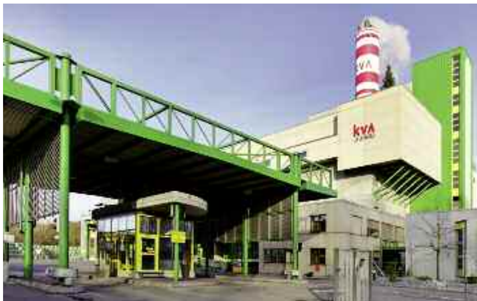
Die Kehrichtverbrennungsanlage Buchs bei Aarau entsorgt bis zu 120 000 Tonnen Abfall jährlich.
