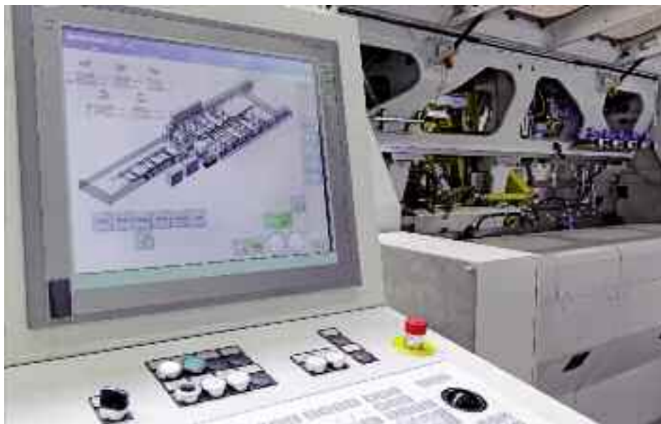
Die Steuerungstopologie für die Schweissanlage und das automatisierte Materialhandling wurde zusammen mit Siemens erarbeitet.
