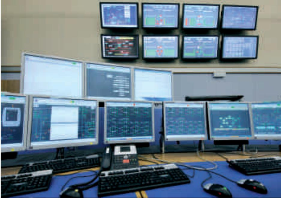
**SCADA total:** Das alles übergreifende Prozessleit- und Visualisierungssystem PVSS im Central Control Centre am CERN sichert die reibungslose Steuerung und Überwachung der gesamten technischen Infrastruktur des Teilchenbeschleunigers unter einer homogenen Bedienoberfläche.
