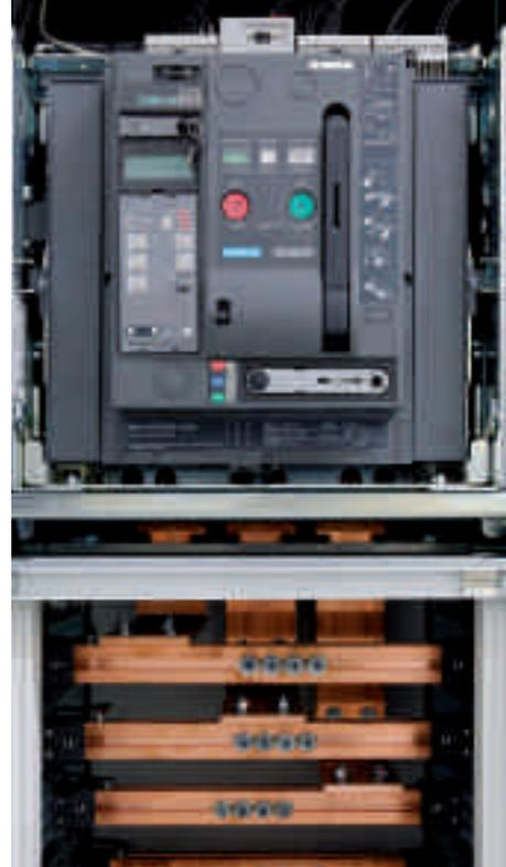
Der Leistungsschalter Sentron 3WL schaltet im Hochdruckpumpwerk Riet Ströme von bis 2 500 A/80 kA.
