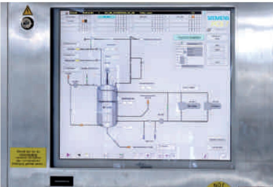
Klares Schaubild der Anlage: Einer der fünf Bildschirme des PCS 7 steht direkt bei der Hydrieranlage. Ein aktives Anzeigen von Störungsquellen sowie der direkte Zugriff über Zugangscodes sind hier sehr schnell möglich.
