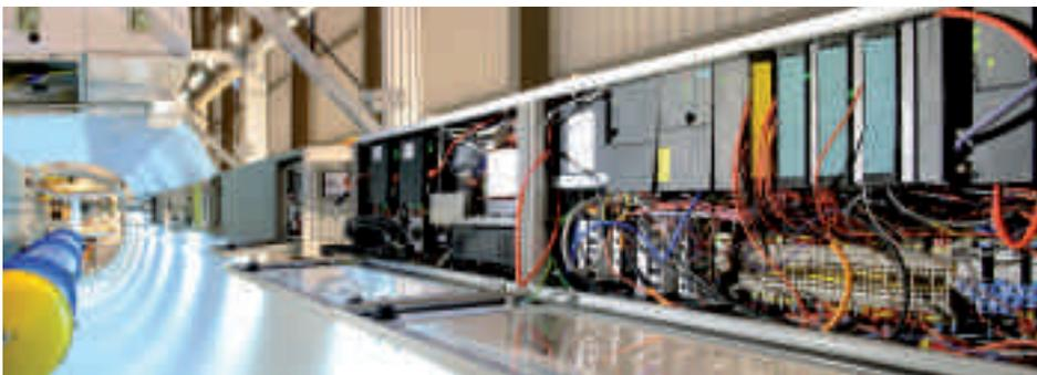
**Auf engstem Raum installiert:** Die fehlersichere Steuerung Simatic S7-300 mit schneller Profinet-CPU 319F-3 PN/DP im Train Inspection Monorail für den Tunnel, einschliesslich Profisafe-Kommunikation zwischen den einzelnen Modulen des Fahrzeugs über IWLAN.
