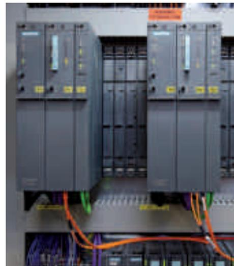
Die zwei identischen und somit redundanten SPS Simatic S7-400H (412H) sorgen für absolute Betriebssicherheit.
