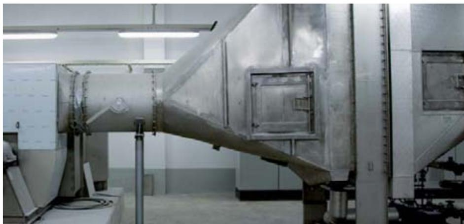
Imposante Gebläse sorgen dafür, dass das Salz schlussendlich trocken in die Lagerhallen und zum Anwender gelangt. Sanftstarter bringen sie schonend und energiesparend auf die Betriebsdrehzahl.
