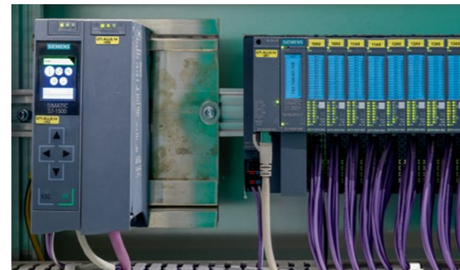
L'automate Simatic S7-1500 et les modules de périphérie ET200SP assurent un climat intérieur agréable dans la manufacture de chocolat Felchlin.
