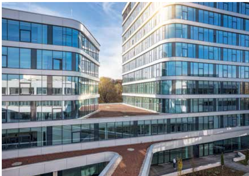
Във филиала на Siemens в Линц се изгражда интелигентна система, комбинирана с инфраструктура за зареждане на електрически автомобили, която няма да позволява надвишаване на предвидената максималната мощност за цялата сграда
