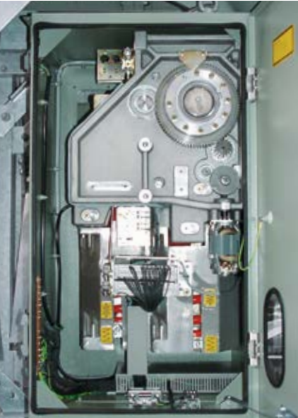
Antriebssteuerschrank mit Federspeicherantrieb des Leistungsschalters
