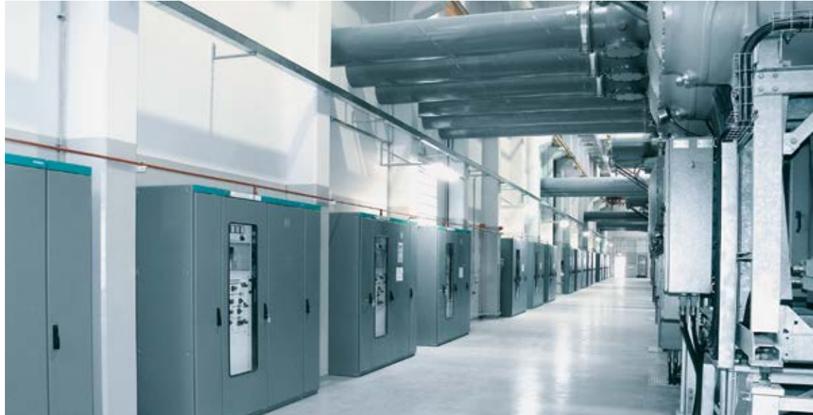
Antriebssteuerschrank mit Federspeicherantrieb des Leistungsschalters
