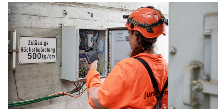
Le système de maintenance prédictive PREMAS® 4.0 développé en collaboration avec Siemens est une solution compacte et facile à utiliser pour les utilisateurs dans les cimenteries et autres installations du secteur industriel.
