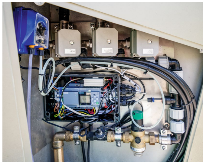
Une alimentation SITOP, une commande LOGO! 8 et trois vannes assurent régulièrement au mouton son arrosage et son alimentation en engrais.
