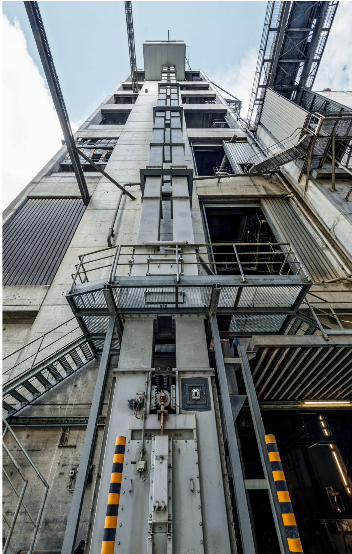
La bande transporteuse d'un élévateur à godets, qui transporte le calcaire broyé pour la production de clinker, est soumise à d'énormes charges. PREMAS® 4.0 permet de surveiller l'installation et de définir le meilleur moment pour une prévision de maintenance.
