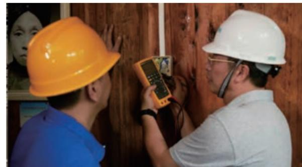
为每幢建筑增加了接地防护系统，为40余户人家进行配电系统的升级改造，还增加了断路器等用电保护产品。
