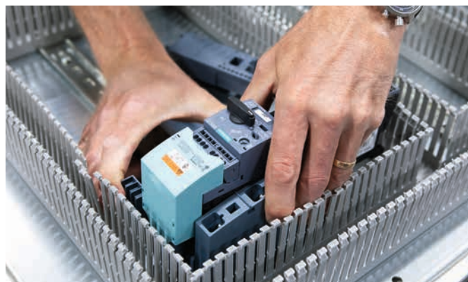
Fjäderanslutning ger snabbare och säkrare montage.
