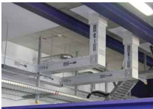
Tokozottsín rendszerek SIVACON 8PS biztosítja az energia biztonságos elosztását az épületen belül.
