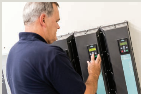
Overmontør Per Sproegel, Erik Lytzen A/S ser lokalt værdierne på Sinamics G120 frekvensomformer.
