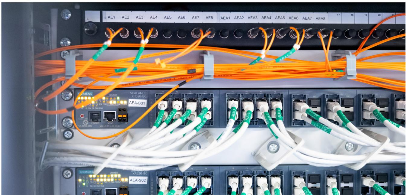
Im Inneren des Systems: Zwei der leistungsstarken Switches SCALANCE XR-500, die den Backbone des Indre Arna Werks bilden.
