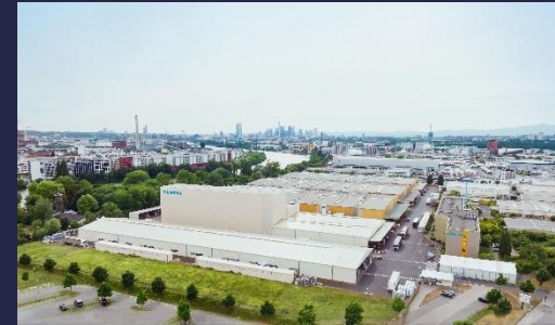
Switchgear factory Frankfurt
