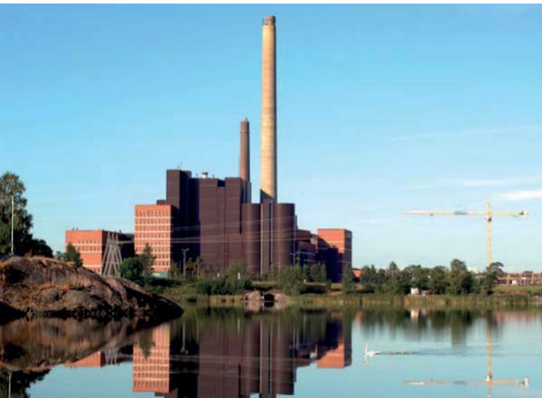
FibroLaser suojaa luotettavasti vaikeiden olosuhteiden laitoksia, kuten voimalaitos. .
