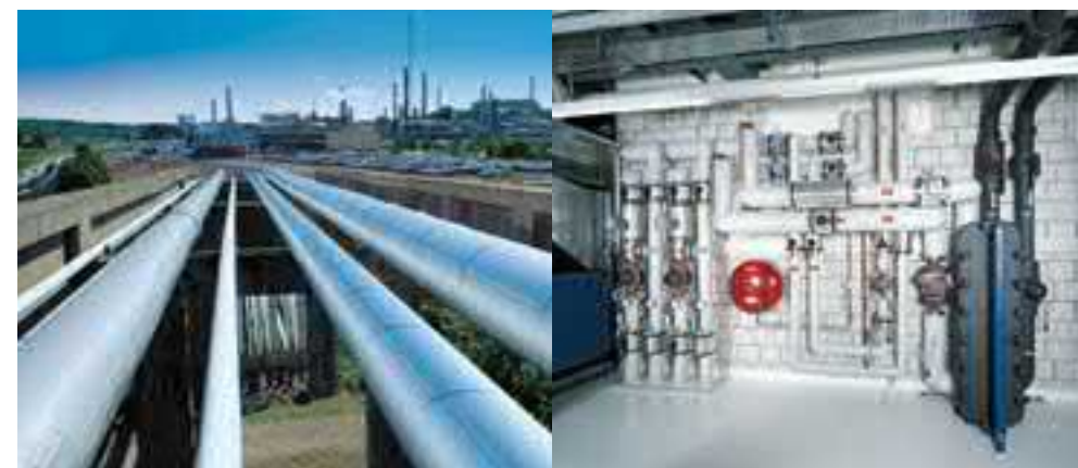
Distribuzione di energia termica
