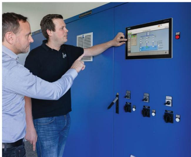
Übersichtlich und intuitiv: Jedes Bauwerk der Wasserversorgung lässt sich direkt vor Ort, von der Leitstelle aus oder neu auch über einen sicheren Webzugriff bedienen.
