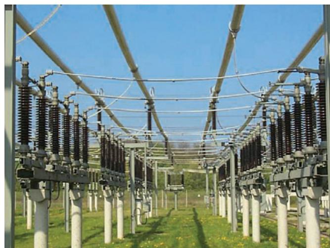
Рис. 3.1-16: Продольное расположение оборудования, РУ 110 кВ, Германия
