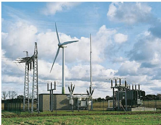
Рис. 3.1-35: КРУЭ типа 8DN8 с номинальным напряжением 145 кВ
