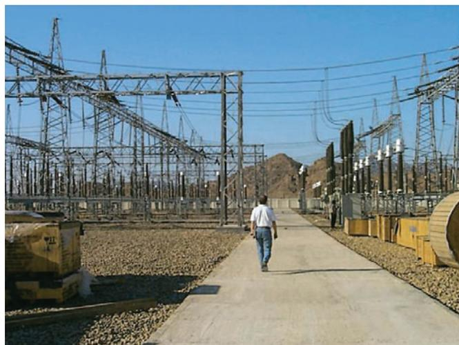
Рис. 3.1-18: Центральное расположение оборудования, РУ 220 кВ, Египет
