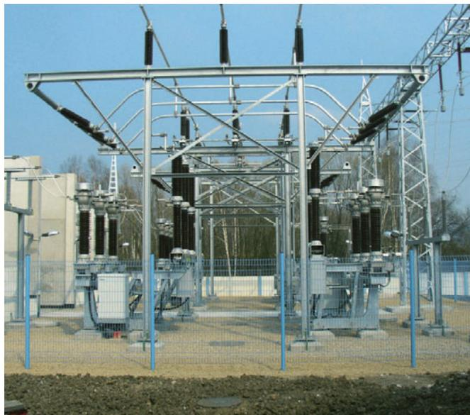
Рис. 3.1-28: Схема «мостик» на модулях SIMOVER, РУ 145 кВ, Чехия
