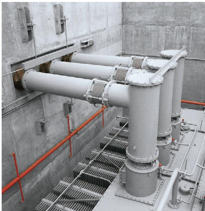
Рис. 3.1-49: Присоединение трансформатора к КРУЭ
