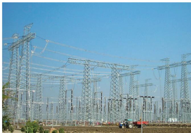
Рис. 3.1-24: РУ 800 кВ, полуторная схема, Индия
