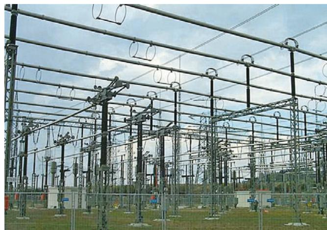
Рис. 3.1-20: Диагональное расположение шинных разъединителей, РУ 380 кВ, Германия
