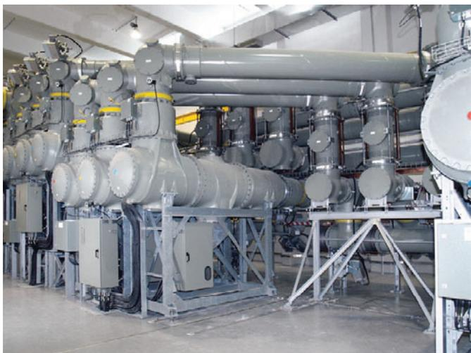
Рис. 3.1-50: КРУЭ 8DQ1 550 кВ, полупотурная схема
