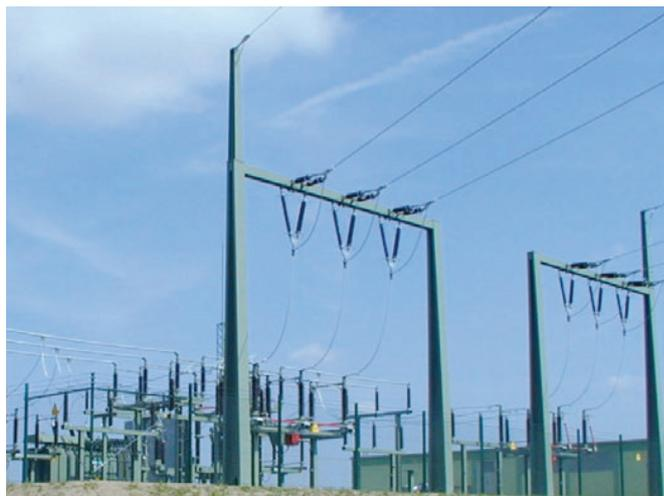
Рис. 3.1-14: РУ 110 кВ по схеме «мостик», Германия
