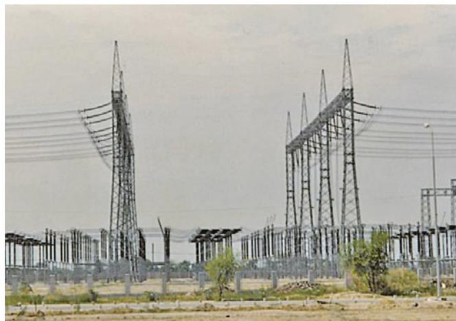
Рис. 3.1-22: РУ 500 кВ, полуторная схема, Пакистан
