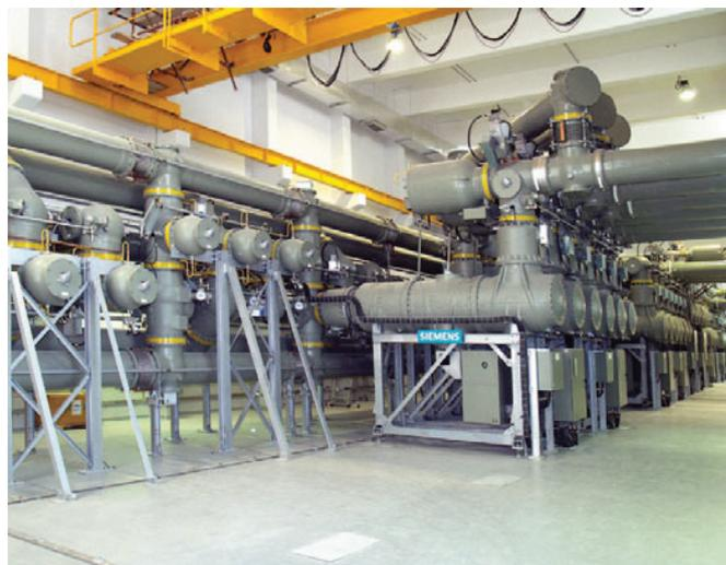
Рис. 3.1-40: Ячейка КРУЭ типа 8DQ1 с номинальным напряжением 420 кВ
