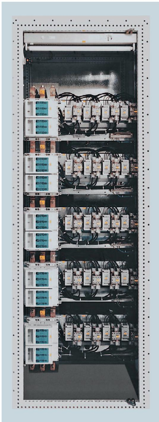
Рис. 3.2-41: Батарея конденсаторов
