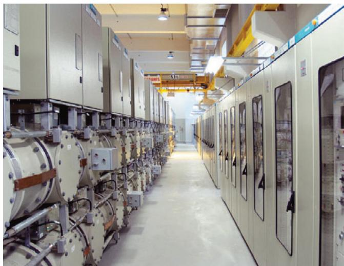
Рис. 3.1-36: Ячейка КРУЭ типа 8DN8 с номинальным напряжением 145 кВ.
