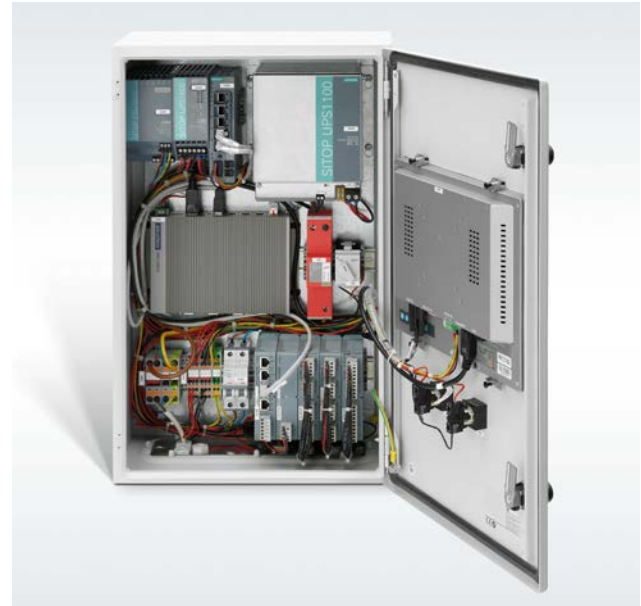
Abb. 6/13: Automatisierungsbox als Systemapplikation des Microgrid Controllers
