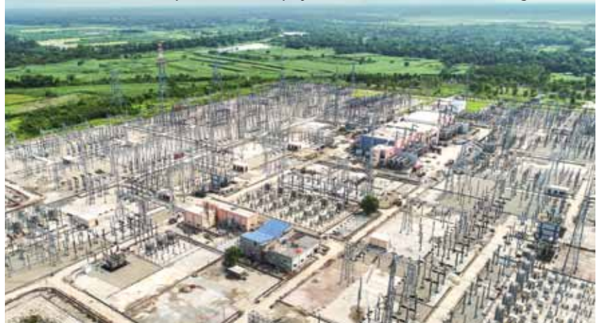
Privire de ansamblu asupra stației de cuplaj scurt HVDC din Bheramara, Bangladesh.
