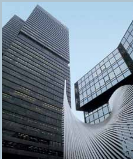
Бесперебойное снабжение высотных зданий
