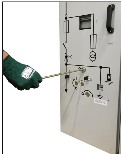
Fig. 200: Push rod inserted
