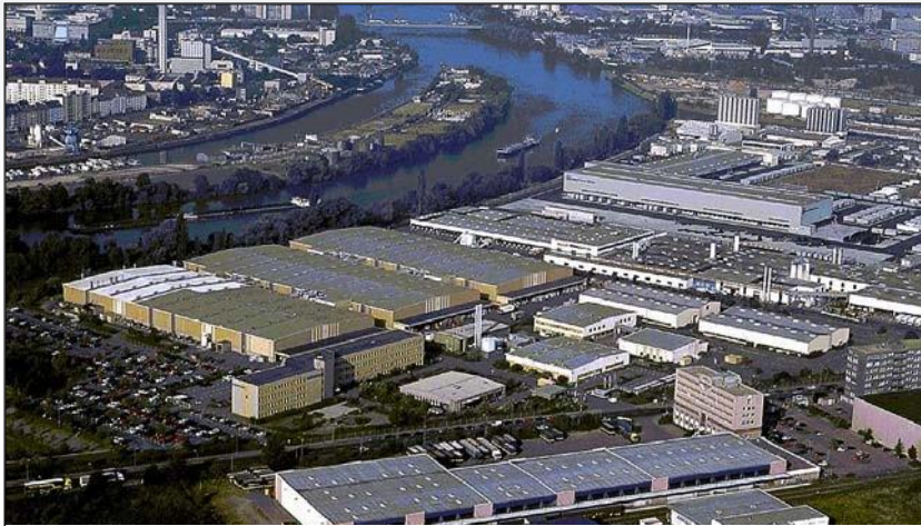
Figura 3 SIEMENS AG Schaltwerk Carl-Benz-Straße, 22 60386 Frankfurt am Main, Deutschland
