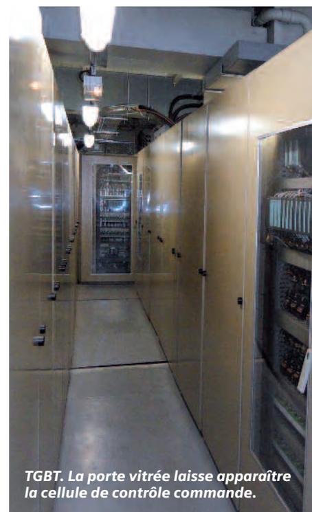
**TGBT. La porte vitrée laisse apparaître la cellule de contrôle commande.**
