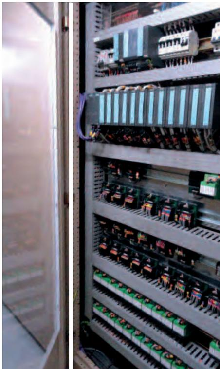
**Cellule de contrôle commande des disjoncteurs, équipée notamment d'un ET200M et d'une alimentation SITOP redondante.**
