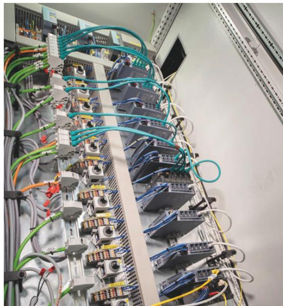
Industrial Security Appliances SCALANCE S615 und ein überlagertes SINEMA Remote Connect-Server stellen sicher, dass nur autorisierte Benutzer auf die Steuerungen in der Produktion zugreifen können.
