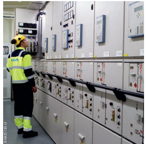
Schaltanlage NXPLUS C 20 kV (Beispiel Data Center Deutschland)
