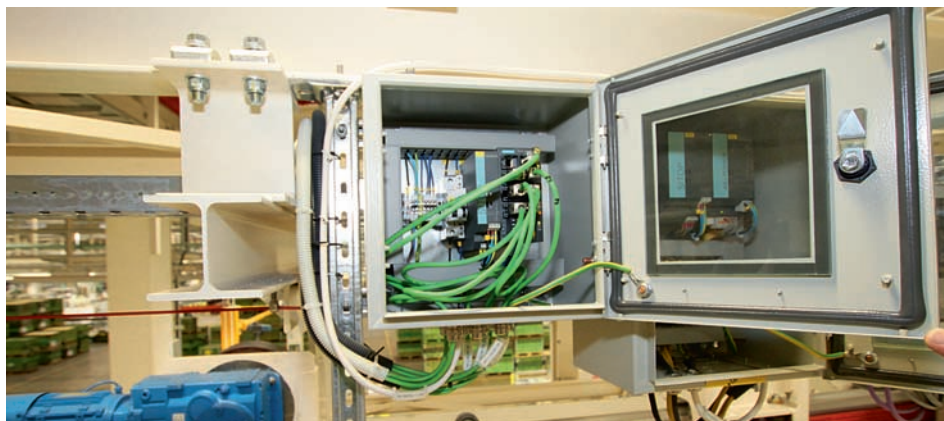
INDUSTRIELLT ETHERNET. En Profinetslinga ligger utmed varje monteringslinje. Parallellt med den ligger AS-Interface-slinga för I/O-kommunikation.
