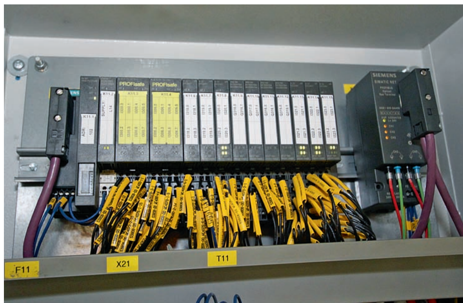
FELSÄKERT. Flera hundra säkra in- och utgångar i anläggningen kommunicerar med det felsäkra styrsystemet.
