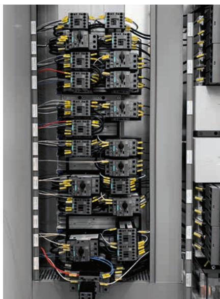
Sirius 3RV-motorskyddsbytare och 3RT-kontaktorer.
