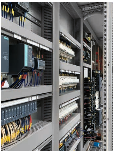
Strömförsörjning, I/O-system, dvärgbrytare och startapparater.
