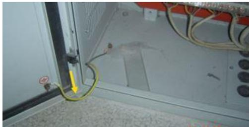
图 7 错误的电控柜接地示例
