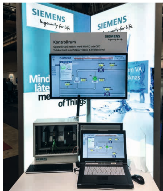
Uppkopplat kontrollrum där pumpstationer övervakades via Siemens koncept för fjärrkommunikation.
