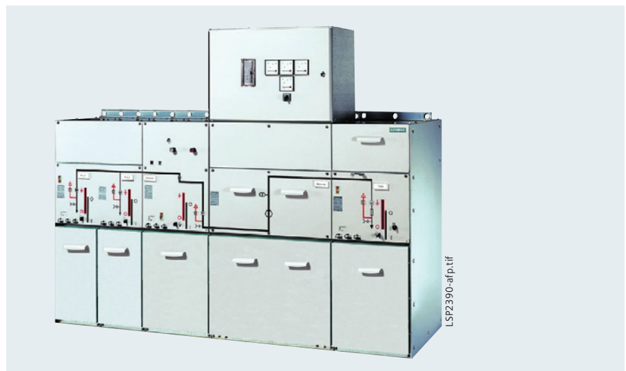
Abb. 5/13 Anwendung in einer Verteilstation
