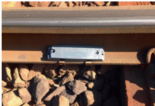
Au niveau de la voie, quatre tags RFID passifs par zone à traiter sont fixés à l'aide d'un dispositif de serrage dans la gorge du rail.
