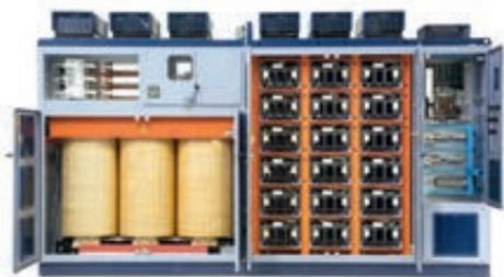
Standard-Niederspannungskomponenten wie Dioden, IGBT'S oder Kunststofffolienkondensatoren auf kosteneffiziente Weise Ausgangsspannungspegel im Mittelspannungsbereich zu erreichen. Der Umrichterwirkungsgrad übersteigt inklusive
