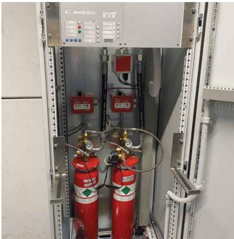
Foto oben: Ausgetüftelte Details im Löschverteiler – platzsparende ausklappbare Steuereinheit
