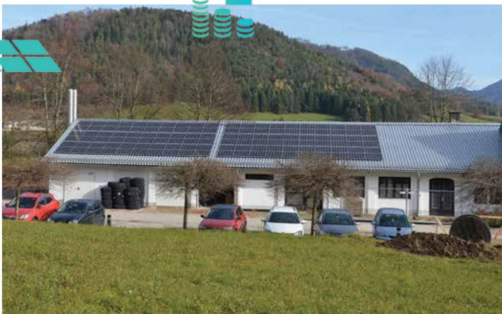
wurden, um das komplette Areal an die neue Heizzentrale anzuschließen. Auch das Dach der Anlage in Micheldorf wurde genutzt. Siemens installierte dort eine Photovoltaikanlage mit einer Leistung von 45 kWp. Die gesamte dadurch erzeugte Energie wird direkt am Standort wieder verwendet. Die übrig gebliebene Restenergie kann dann in das Stromnetz eingespeist werden.
