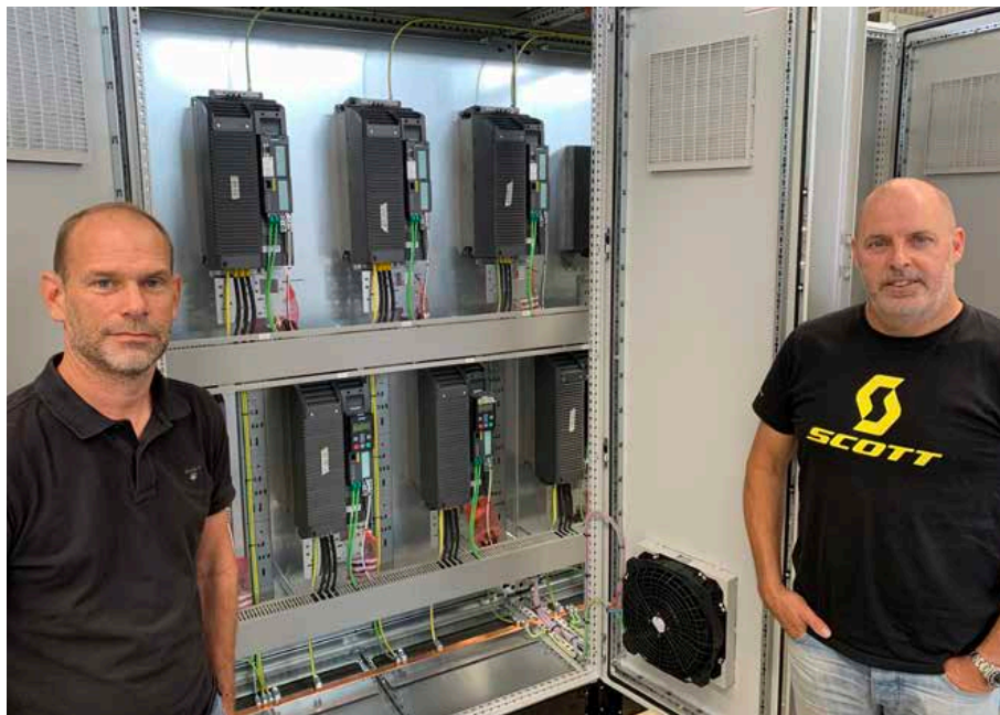
Jonas Emanuelsson, projektledare, och Sven Dalenberg, affärsansvarig för industriinstallationer, på Dalenbergs som projekterar, konstruerar, monterar, installerar och idriftsätter el- och automationsskåp för såglinjer. Många gråa, fina skåp blir det.
