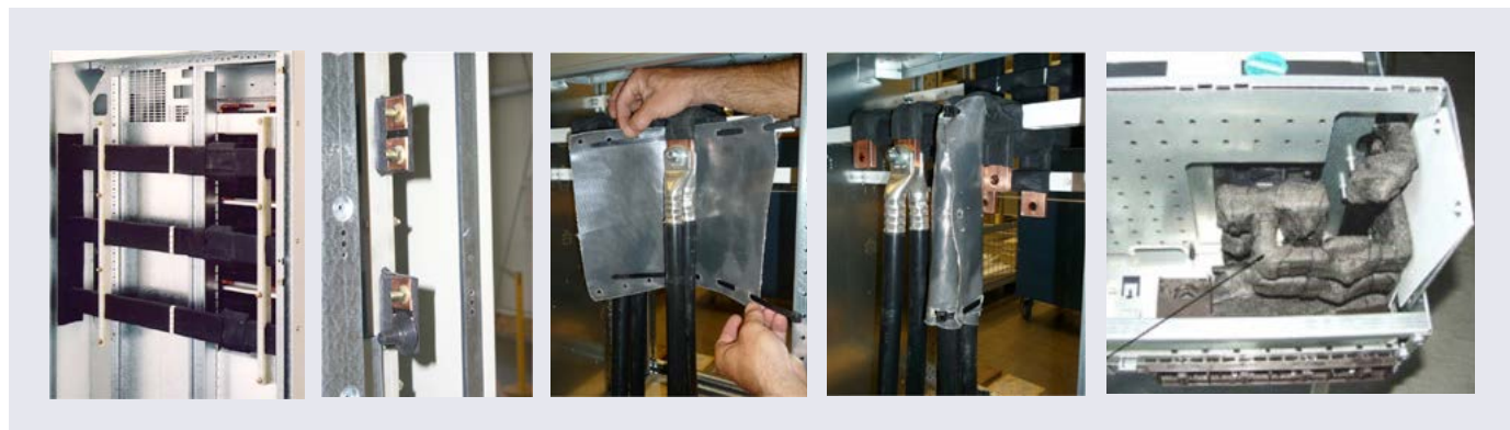
Abb. 8: Passives System zur Verhinderung eines Störlichtbogens, mit isolierter Sammelschiene, Feldverbinder, Einspeisung und Abgang sowie MCC-Einschub
