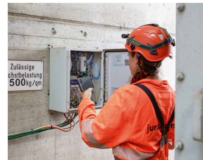
Das zusammen mit Siemens entwickelte Predictive-Maintenance-System PREMÁS® 4.0 ist eine kompakte und benutzerfreundliche Lösung für Zementwerke und andere Industrieanlagen.
