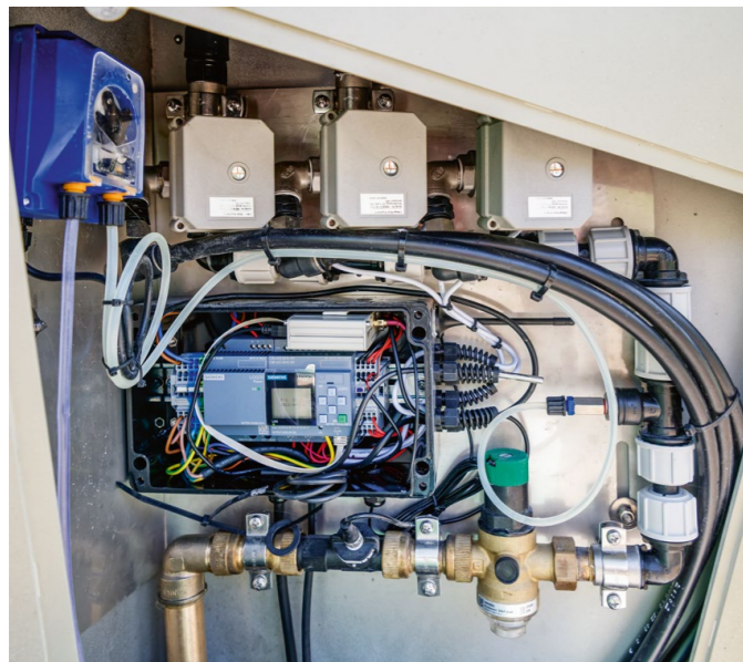
Eine Sitop Stromversorgung, eine Logo 8 Steuerung und drei Ventile sorgen für die regelmässige Bewässerung und Düngung des Schafs.
