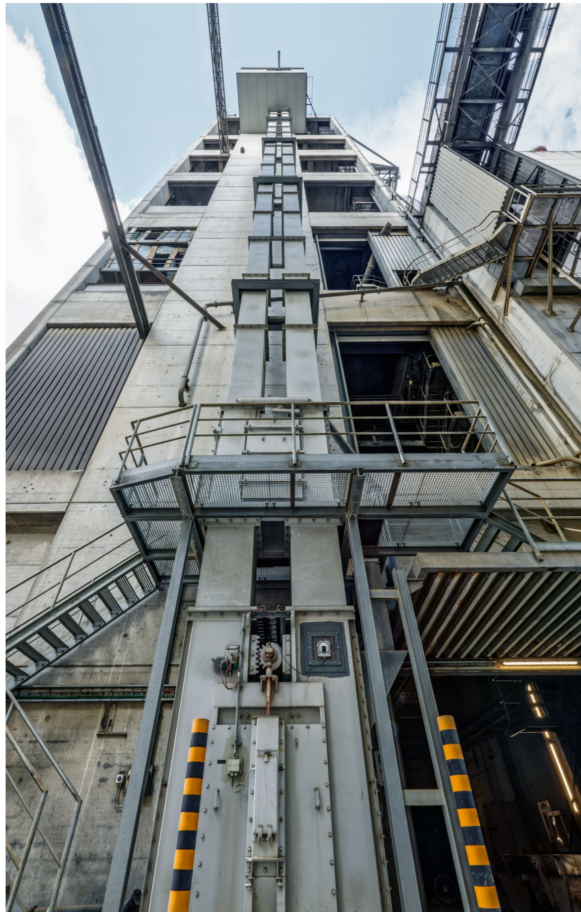
Der Gurt eines Gurtbecherwerks, das gemahlene Kalkstein für die Klinkerproduktion transportiert, ist enormen Belastungen ausgesetzt. Mit PREMÁS® 4.0 lässt sich die Anlage überwachen und den besten Zeitpunkt für eine Wartungsvorhersagen.
