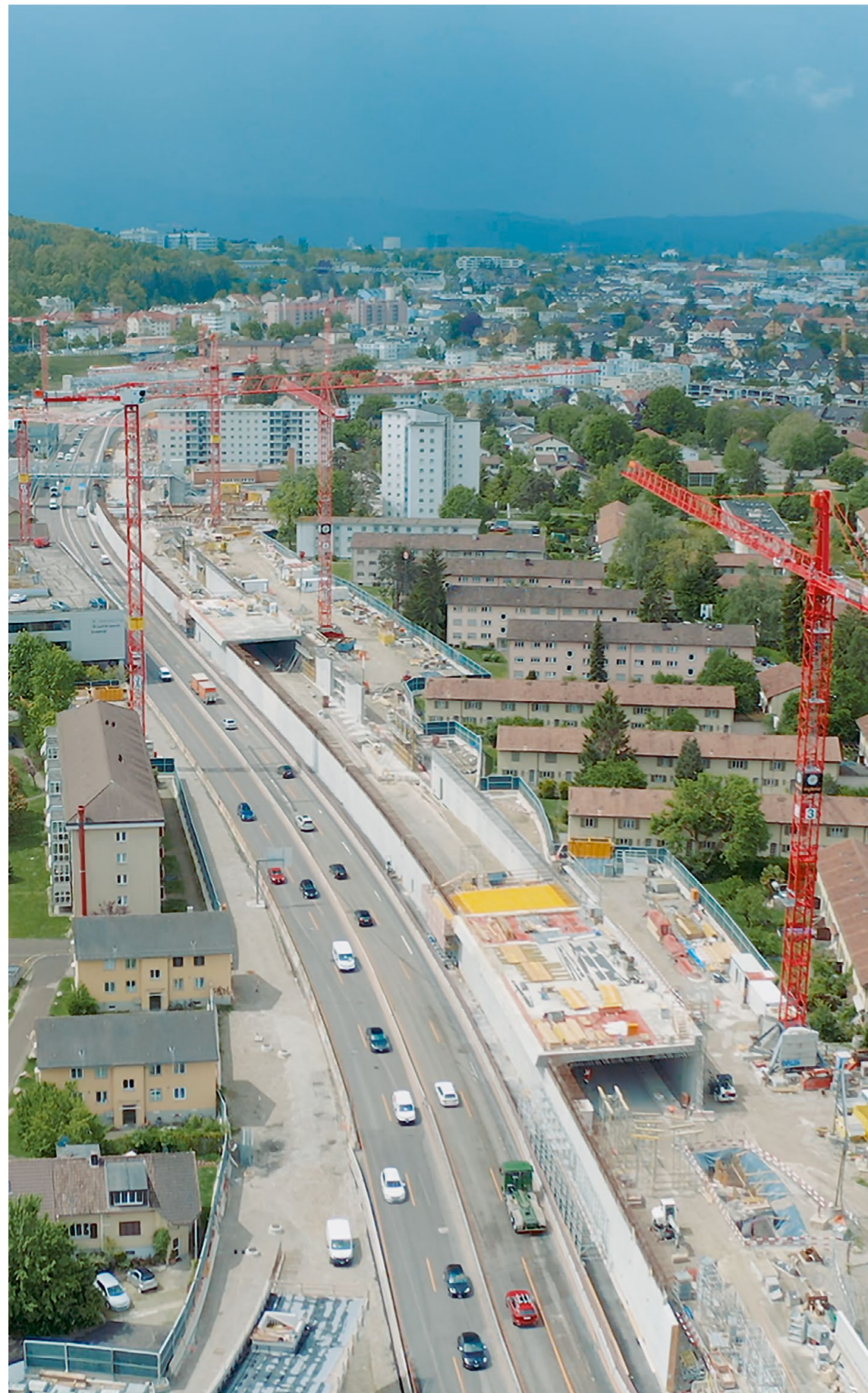
Überblick auf die Grossbaustelle der Einhausung Schwamendingen.
