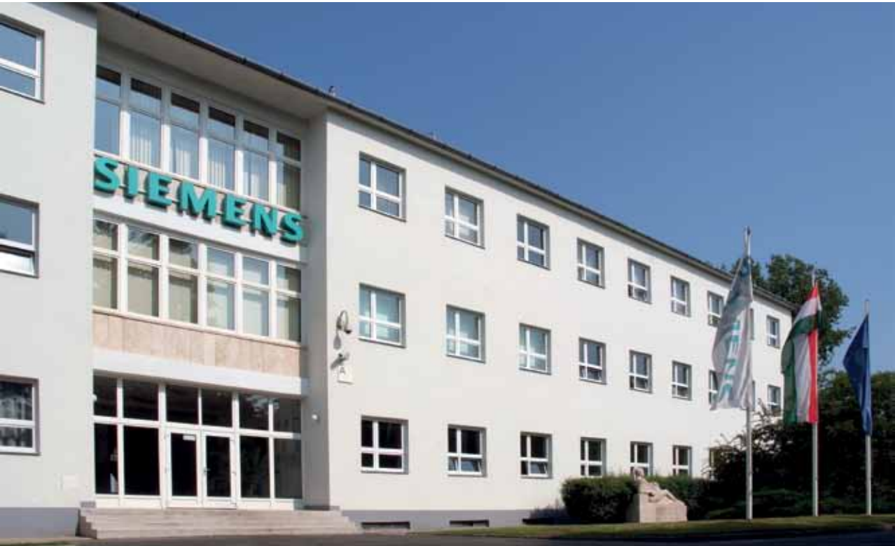
BALRA – A II. Rákóczi Ferenc úti telephely épülete
