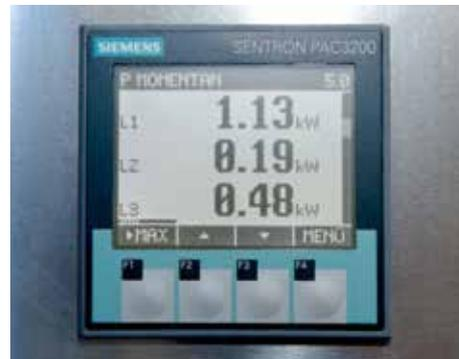
Oben: Die Energiedaten der Anlage werden mit dem Multifunktionsmessgerät Sentron PAC3200 erfasst und regelmässig ausgewertet.
