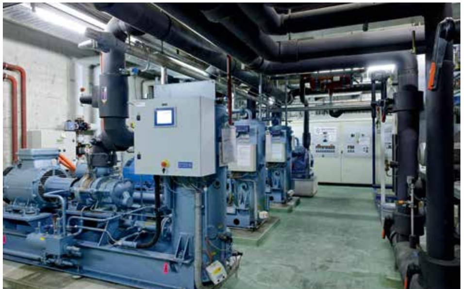
Seit Januar 2011 läuft das Energie- und Lastmanagement-System bei Coop in Gossau reibungslos trotz rauer Umgebung: Der WinCC-Industrierechner steht mitten in einer Heizzentrale des Verteilzentrums, in der eine Durchschnittstemperatur von 35 Grad Celsius herrscht.
