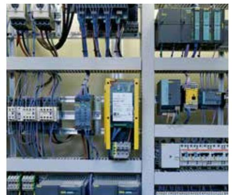
Über Profibus DP kommuniziert die Steuerung mit den Frequenzumrichtern.
