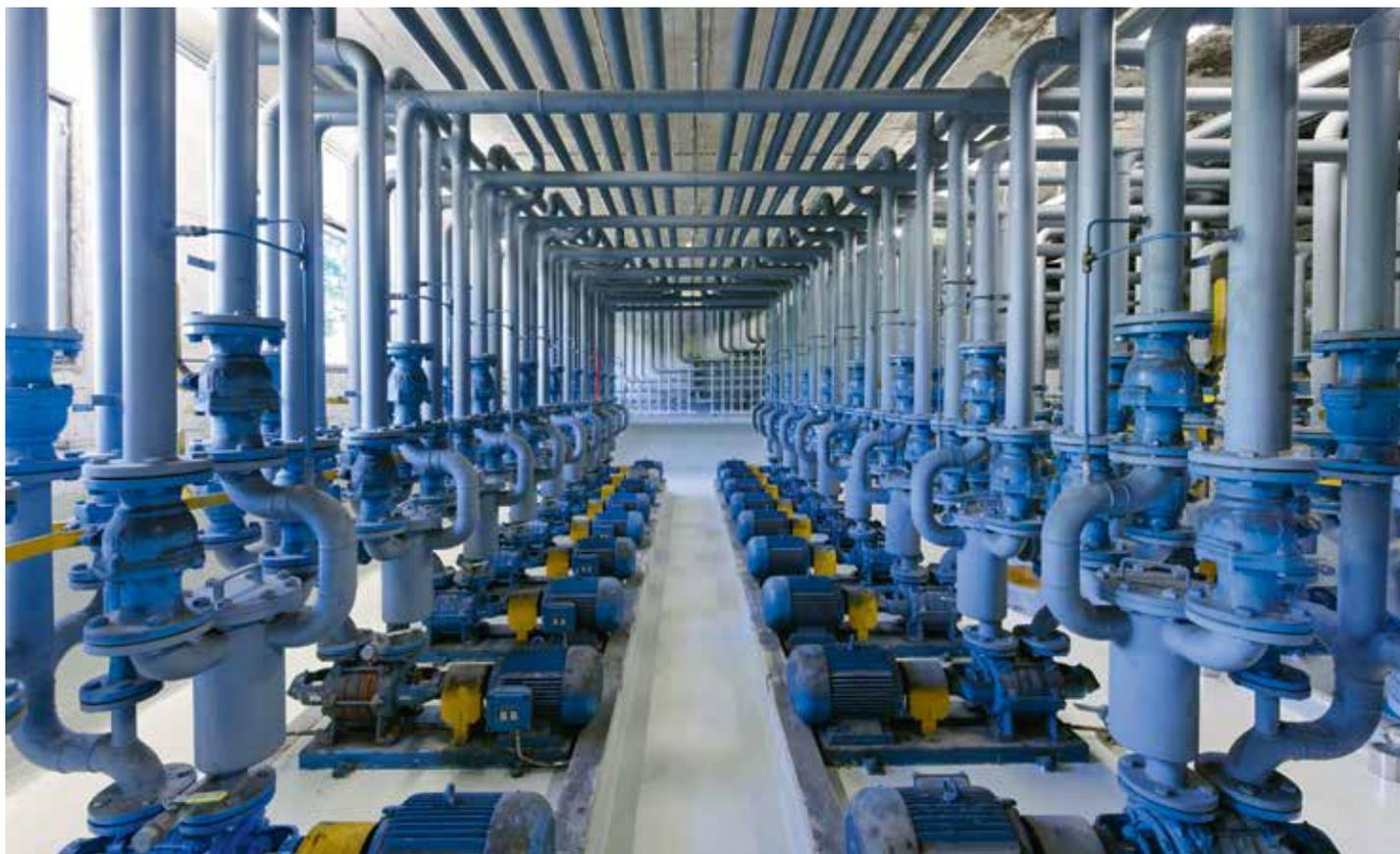
Über Pumpen wird aus den Tanks Flüssigkeit in die Herstellung weitergeleitet. Dieser Prozess muss zuverlässig funktionieren. Weil die Lösungsmittel entzündlich sind, muss die Dichtigkeit der Tanks, Pumpen und Leitungen ständig überwacht werden.
