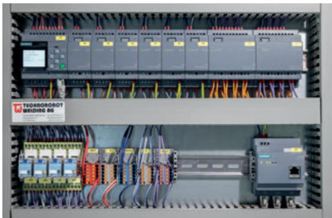
Die Logo Steuerung kommuniziert mit dem Gebäudeleitsystem und wertet von Sensoren gemessene Parameter wie Temperatur, CO<sub>2</sub>-Gehalt und Partikel in der Luft aus für eine optimale Klimatisierung.
