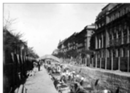
Kisföldalatti építés, 1890 körül
