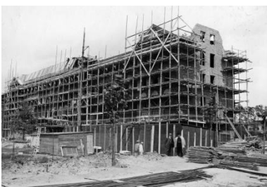
Arbeiten am ersten Bauabschnitt, Berlin 1910
